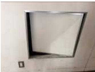
ホール点検口（破損開口）と柱のガード破損
