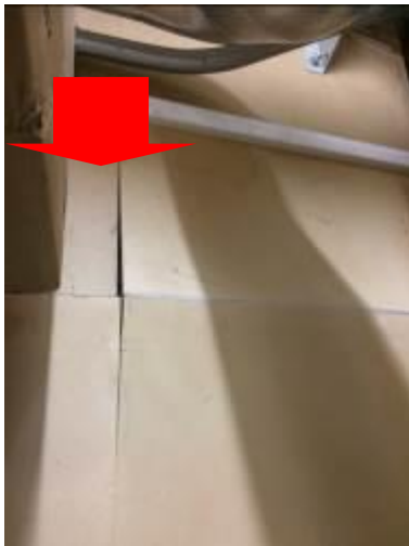
写真10 9月地震後、壁のボードがめくれ上がった 写真11 経年劣化による壁の崩れ 写真12 9月の地震後壁に亀裂発生
