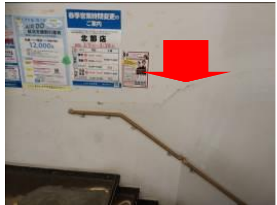
写真10 9月地震後、壁のボードがめくれ上がった 写真11 経年劣化による壁の崩れ 写真12 9月の地震後壁に亀裂発生
