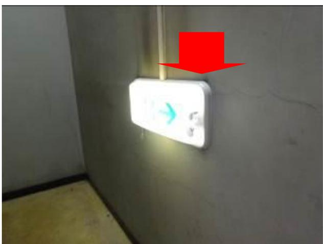
(写真5) 非常灯のカバーが破損している
