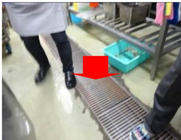
(写真2)排水溝の上が水で滑りやすい
