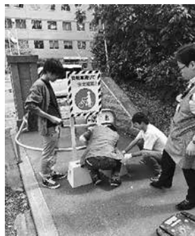
北大構内での看板設置作業
