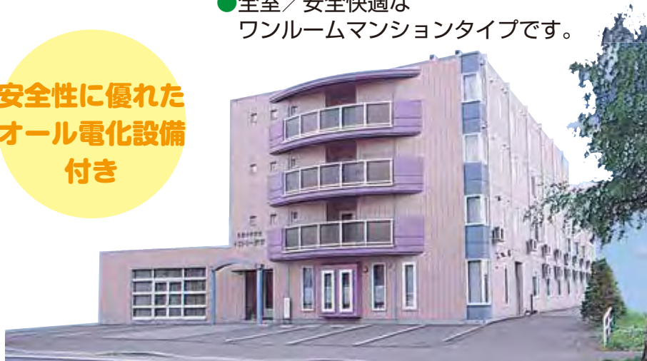
鉄筋コンクリート造 地上4階 全58室(個室)
