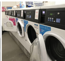
ランドリーの設備
